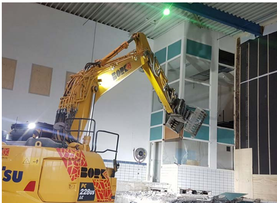
Bork Sloopwerken sloop zwembad Stadskanaal.
