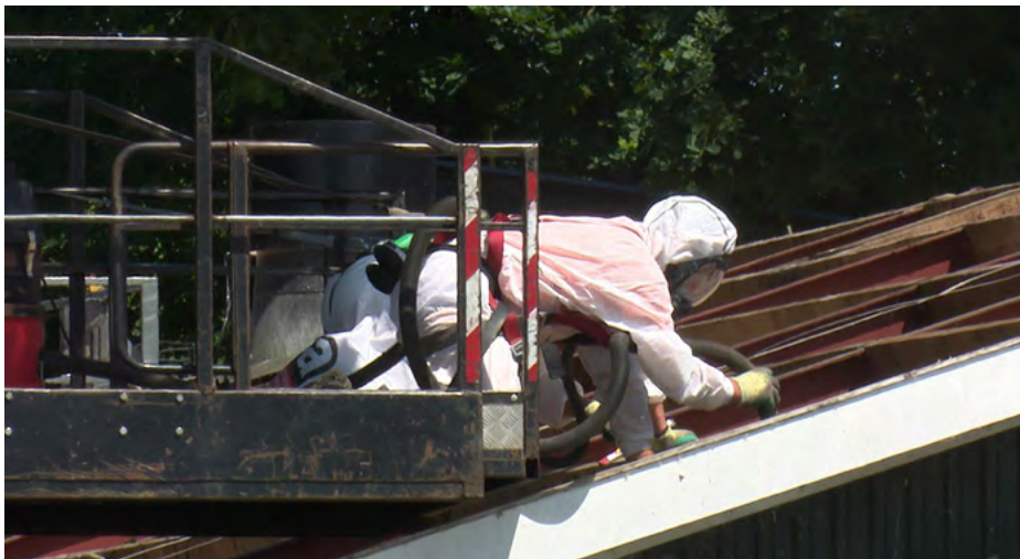
Verwijdering van een asbestdak.
