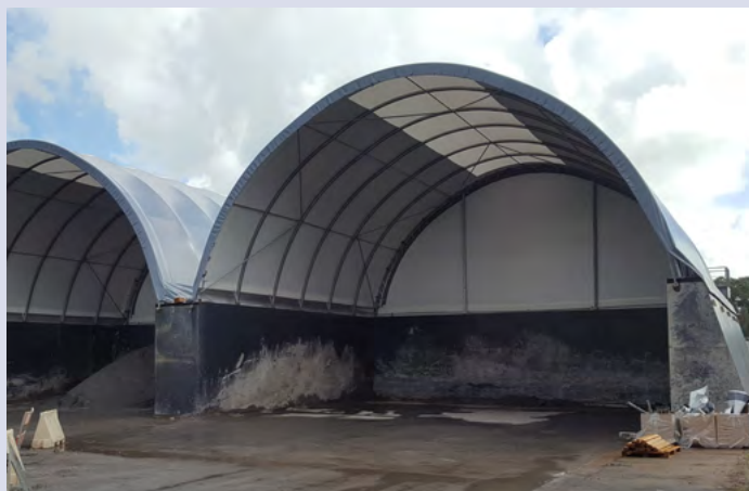
Overkappingen op stalen keerwanden bij Boskalis / HVC in Alkmaar.
