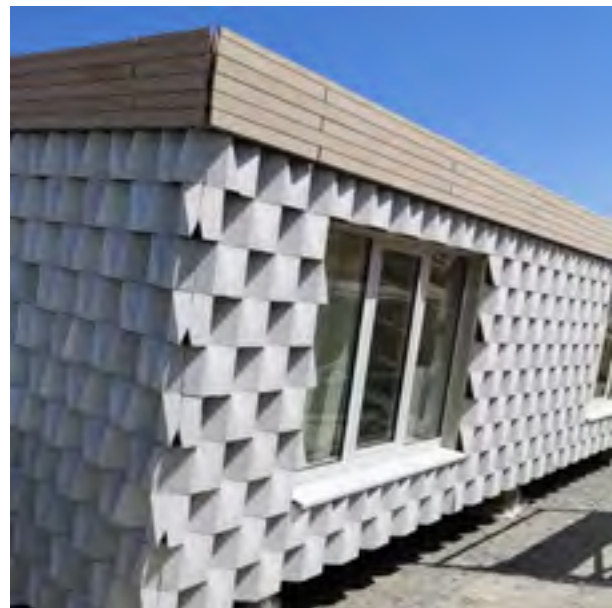
Afhankelijk van temperatuur en zonnestand zijn de geveldelen meer of minder open te zetten voor extra ventilatie.
