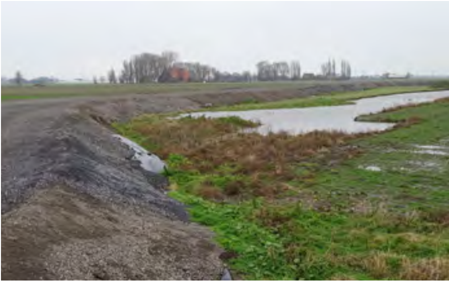
De gewraakte 'slakkenweg' naar het baggerdepot.
