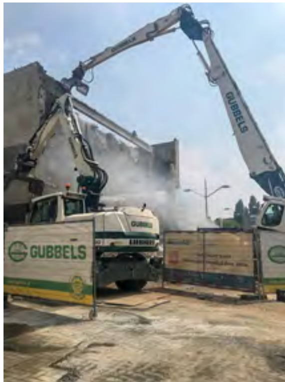
Gedeeltelijke sloop van het stadskantoor van de gemeente Tilburg.
