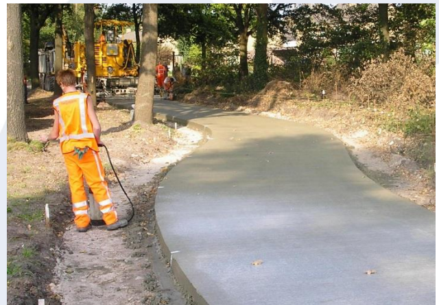
Figuur 5. Aanleg fietspad met recyclingbeton
